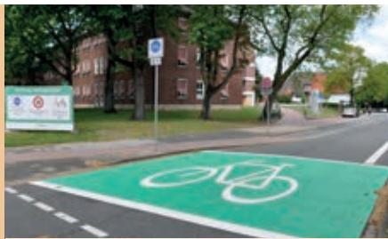
Fahrradstraßen werden im Eingangsbereich großflächig markiert.
