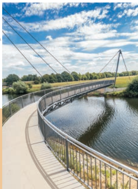
Die neue Rad- und Fußwegebrücke in Meppen führt direkt in die Naturräume des Interreg-Projekts „Grenzenlos Moor“ und verkürzt viele Wege.
