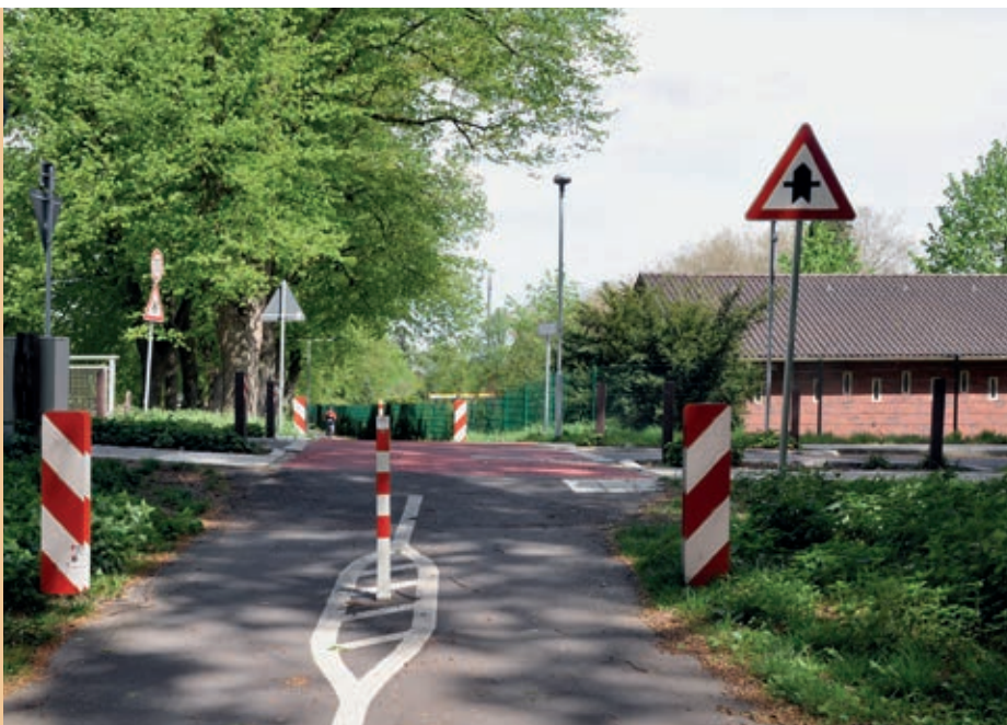
Die Komfortroute wurde gegenüber Nebenstraßen bevorrechtigt. Zur Erhöhung der Verkehrssicherheit wurden an dieser Kreuzung die Sichtverhältnisse durch verschiedene Veränderungen deutlich verbessert.
