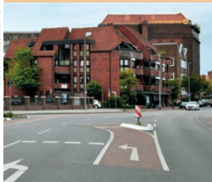
Linksabbiegende Radfahrerinnen und Radfahrer können sich durch eine kleine Mittelinsel geschützt einordnen.
