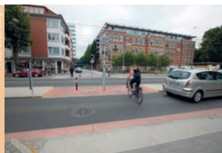
Nachher: Mit der Umgestaltung entstand ein sicherer Querungspunkt mit Aufstellflächen – an den Gleisen auch signalgesichert.
