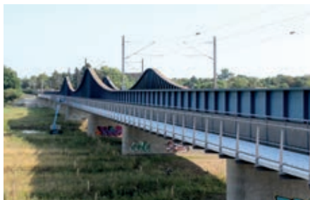
Die neue Radbrücke wurde mit Stahlbetonplatten direkt an die Allerbrücke montiert.
