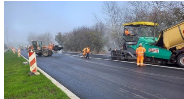
Sanierung Straße „Zum Nordkai“
