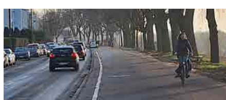
Nach dem Ausbau: 4,25 m breiter Premiumradweg mit 0,75 m breitem Sicherheitstrennstreifen.
