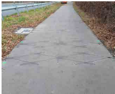
Dauerzählstelle mit Schacht auf einem Radweg an einer Landesstraße.
