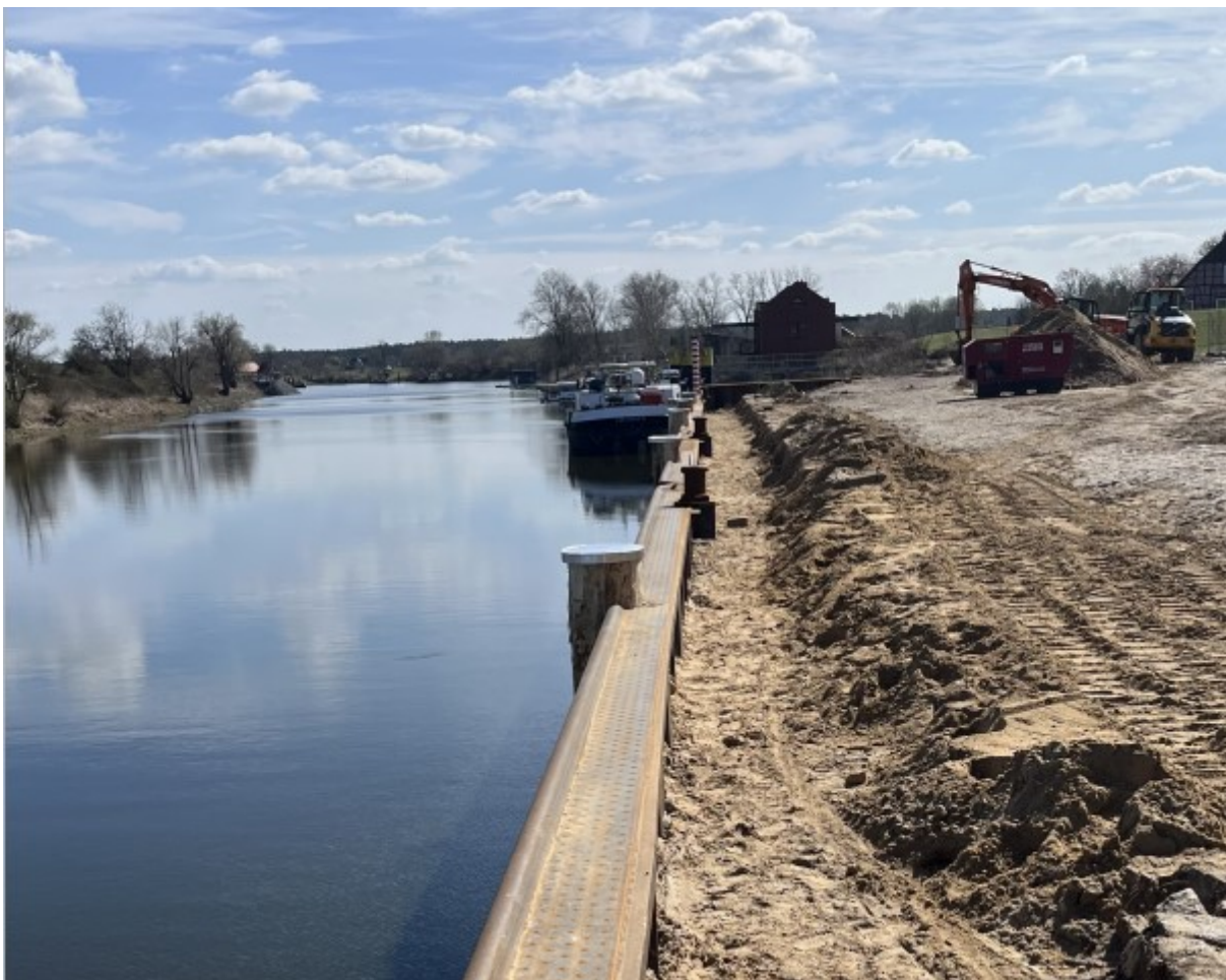
Stand der Baumaßnahmen in 04.2026 (Foto: Stadt Bleckede)
