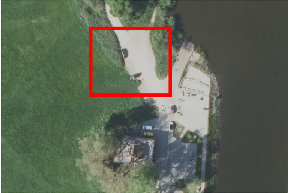
Luftbild des Fähranlegers Bleckede; rot umrahmt: Sandfläche, für die die Stadt Bleckede die Schaffung von Parkplatzflächen beantragt hat (Quelle: Stadt Bleckede)
