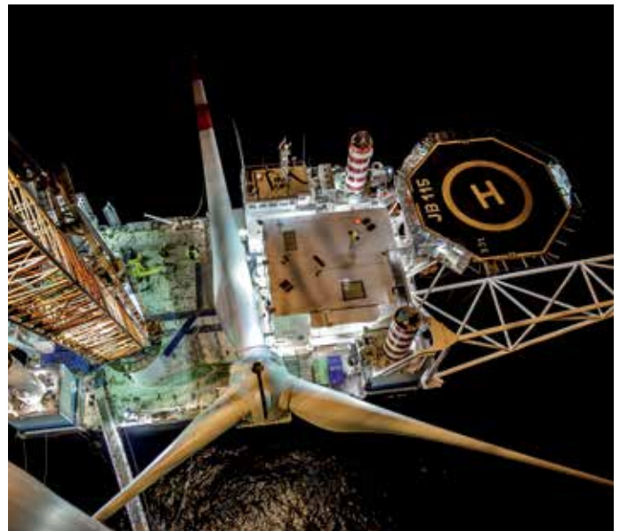
Der Rotorstern (Durchmesser 122 m) wird zur Gondel gezogen
