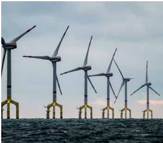
Die 5.0-Megawatt-Anlagen stehen in 40 Meter tiefem Wasser
