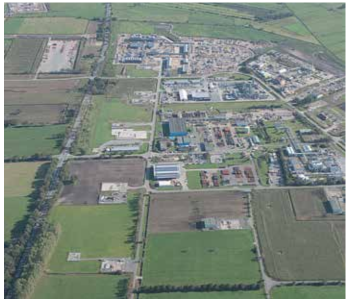
Betriebsanlagen Speicherprojekt Etzel – Storage Facilities Etzel
